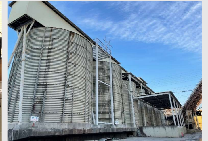
骨材貯蔵設備
